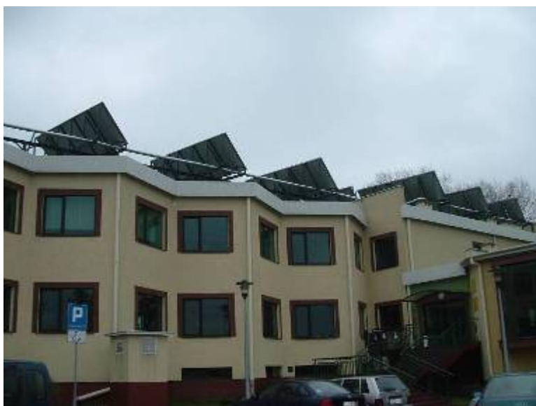
Rys. 30: Widok ogólny na system kolektorów słonecznych na budynku basenu kąpielowego w Gostyninie.
