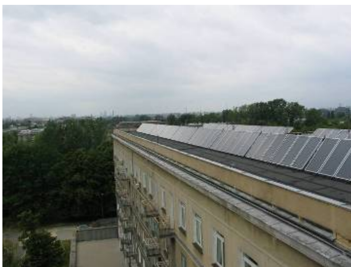
Rys. 29: Widok ogólny na system kolektorów słonecznych dla szpitala w Warszawie
