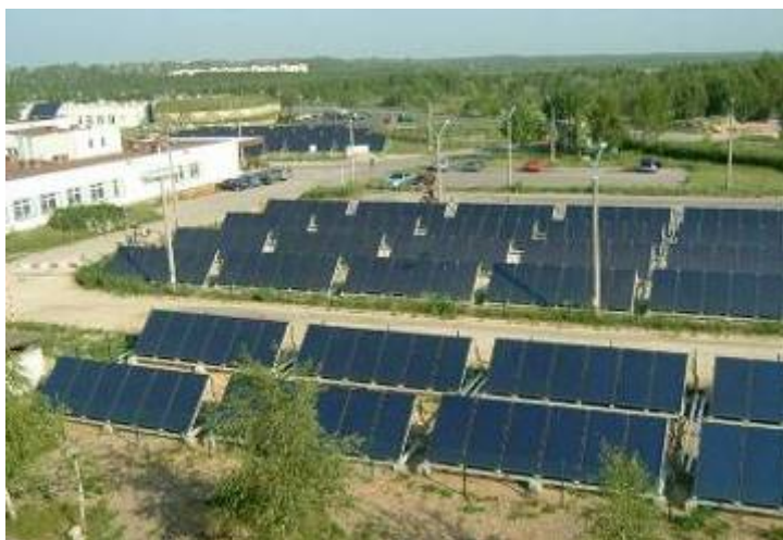
Rys. 32: Widok ogólny na największą instalację słoneczną do przygotowania c.w.u. dla szpitala w Częstochowie.
