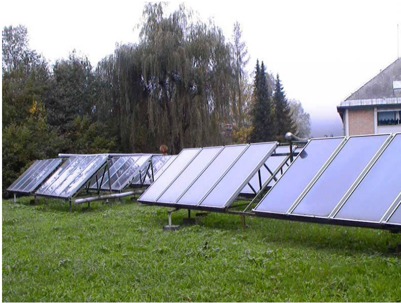
Slika 16: Ploščni SSE pri Domu Tisje
