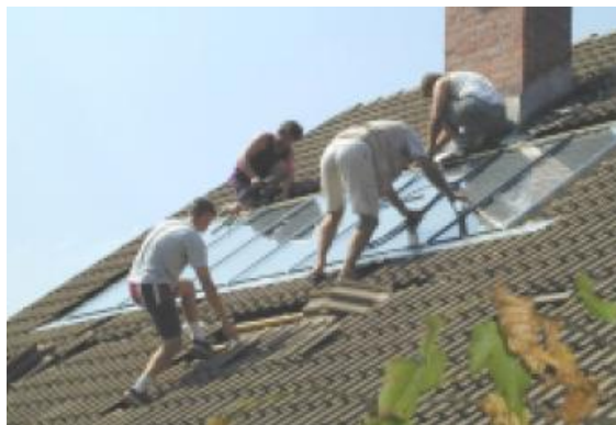
Slika 11: Privatni investitorji v sodelovanju s kampanjo 'samogradnja sprejemnikov sončne energije', so v letu 2005 izdelali 145 sistemov za ogrevanje sanitarne vode. To predstavlja 24% tržni delež. (Vir: GI ZRMK)
