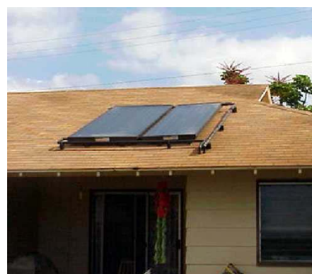
Slika 23: običajni sistem za pripravo tople sanitarne vode za enodružinsko hišo (Vir: FME-Diplomska naloga)
