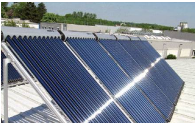
Slika 17: Vakuumski cevni SSE
